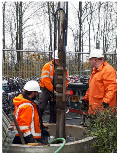
groot onderhoud aan één van de warmtebronnen
